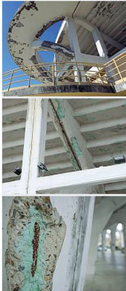
Problemi Alcuni dei tanti problemi che stanno minando la struttura dello stadio Franchi. Sotto, l'impianto di Pier Luigi Nervi ( Cambi/Sestini )
