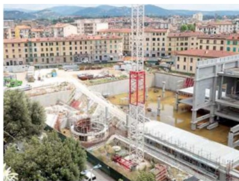
Il cantiere di via Mariti sotto sequestro
